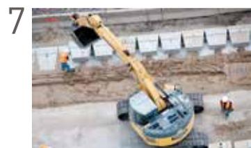
Mise en place des couches supplémentaires du mur de soutènement autoportant
