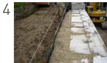
Mise en place du matériau de drainage
