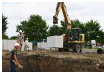
3) Plaatsen van de grafkelders
