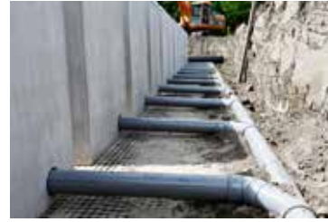
7) Aansluitmof van vochttafvoer en beluchtingspijpen
