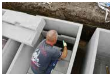
5.1) De laatste plaat heeft een handgreep
