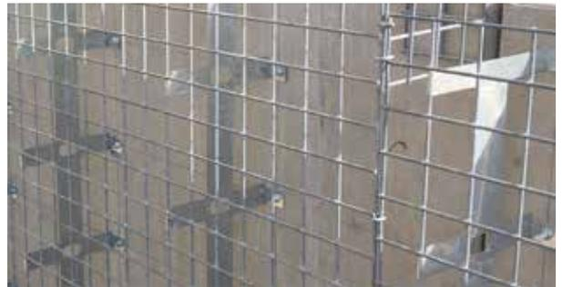
Colonne fix avec plaquette et vis
