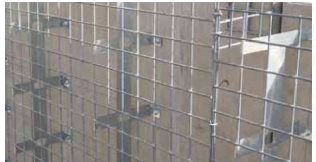
Afstandhouder bevestigd met Turboschroeven
