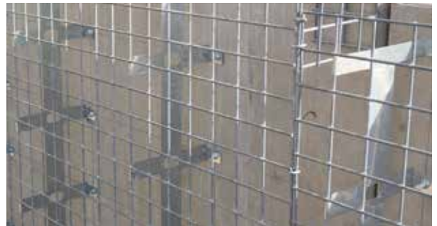
Afstandhouder bevestigd met Turboschroeven
