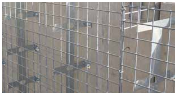
Afstandhouder bevestigd met Turboschroeven
